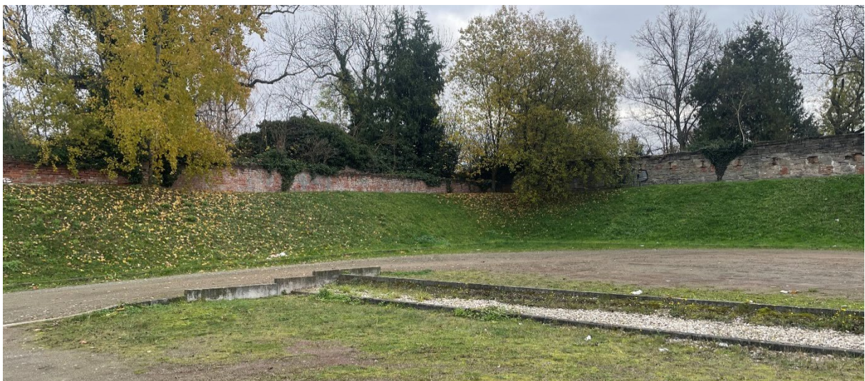
Abbildung 3: Denkmalschutz Mauer am südlichen Ende des Parkplatzes bzw. Blick Richtung Johannesfriedhof (Foto: Fabian Fröhlich)
